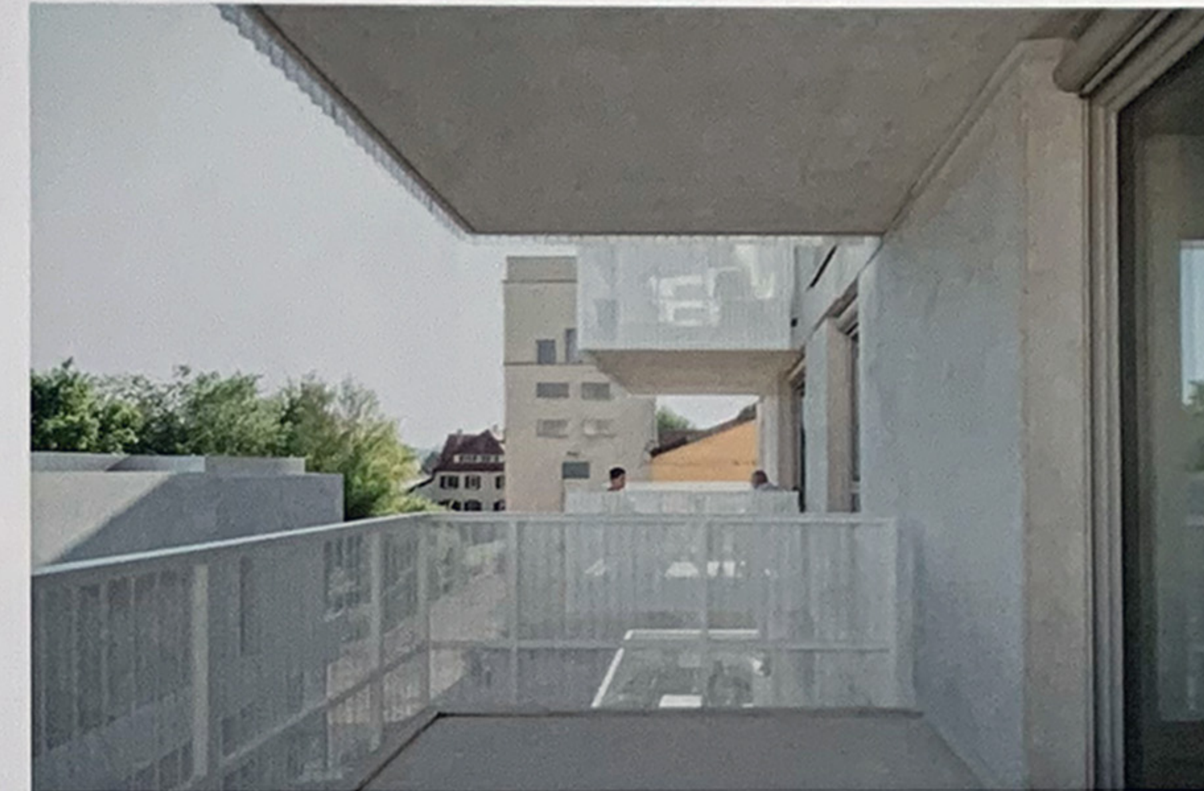
Balkone mit halbdurchsichtiger Brüstung
