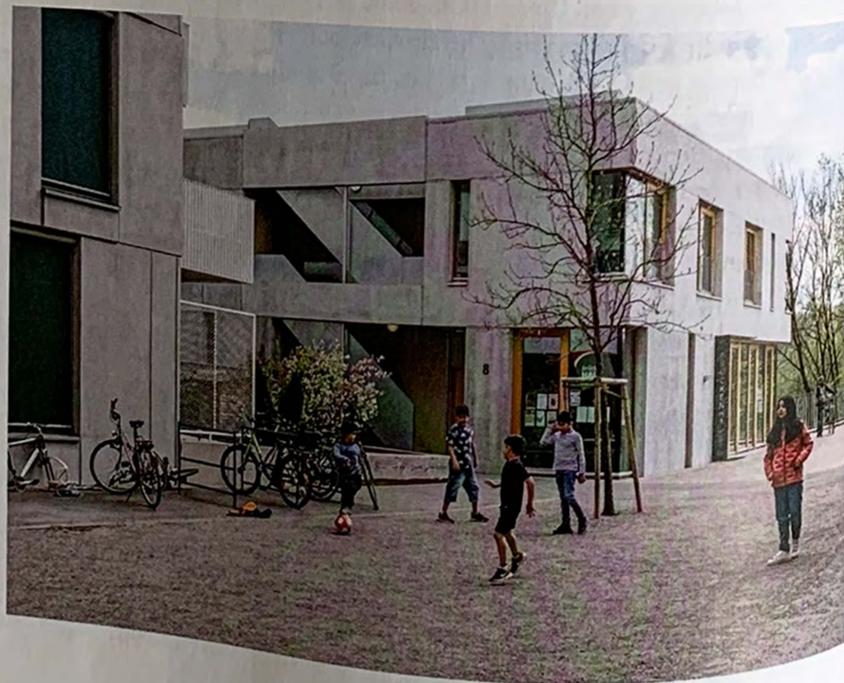
Zweites Wohnzimmer: das Brückenhaus als Quartiers-Treff für die gesamte Nachbarschaft. Daneben das Haus am Park mit Wohnungen für Geflüchtete und alteingesessene Tübinger
